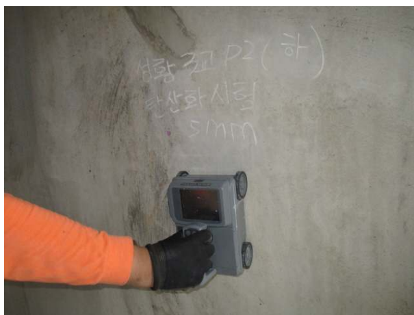
철근 피복두께 측정
