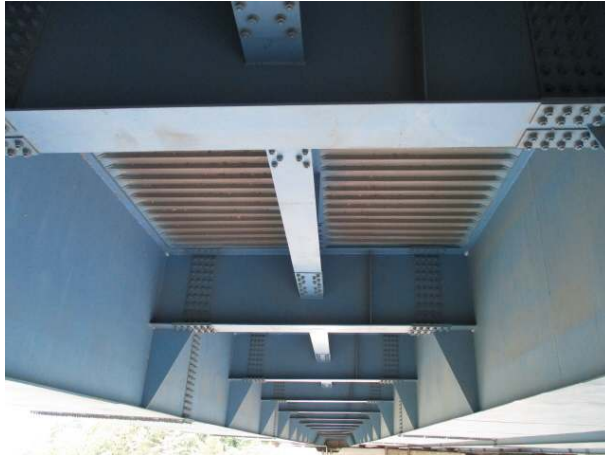
바닥판 하면(DECK) 전경
