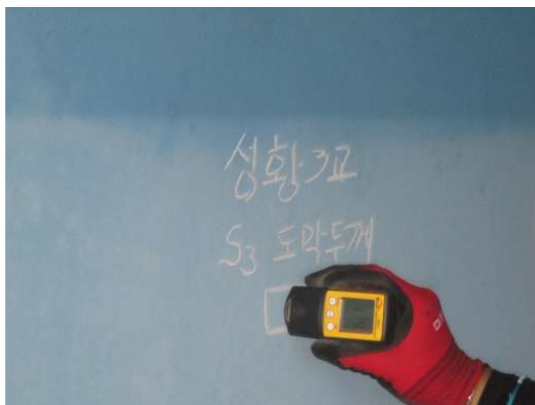
거더 외부 도막두께 측정
