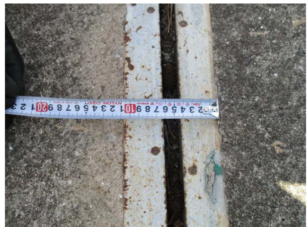
신축이음 유간거리 측정
