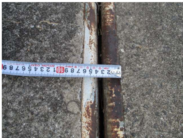
신축이음 유간거리 측정
